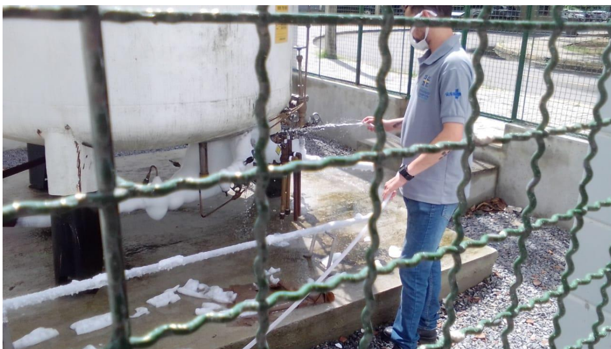
Descongelamento do tanque de oxigênio
